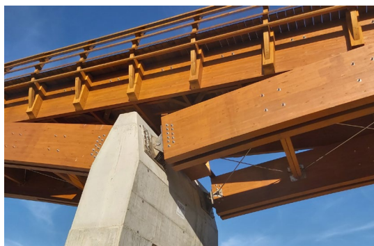
Figura 2. Detalles de las uniones articuladas: (a) a las pilas y (b) entre partes del arco.
